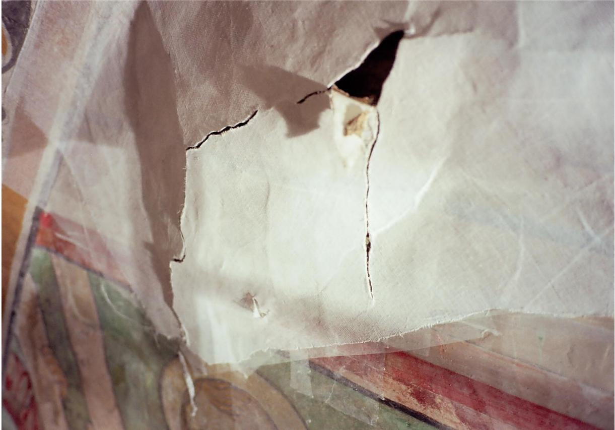
Die Putzblase ließ sich wegen der Verspannung der einzelnen Putzschollen nicht einfach wieder anlegen. So wurde zunächst die Sicherungsbeklebung mit Gewebe verstärkt.
