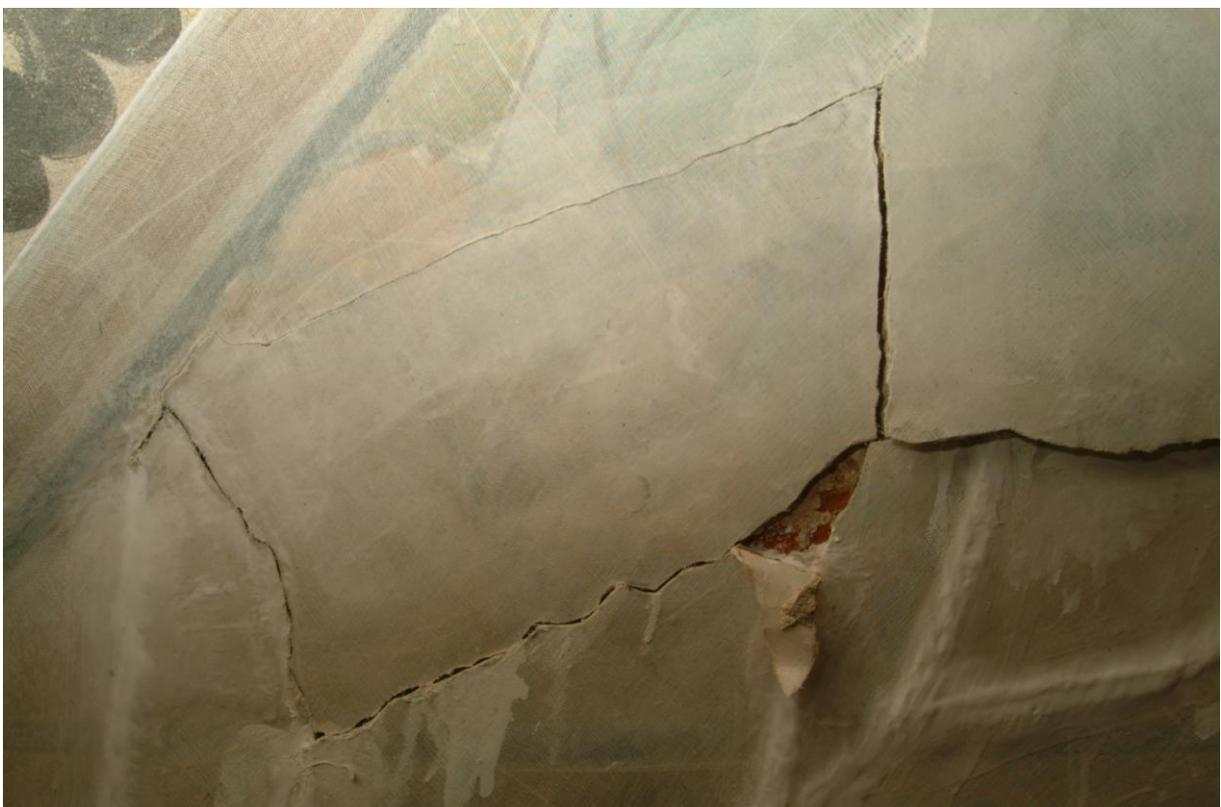
Zum Planieren mußten die Putzschollen einzeln abgenommen, beschnitten und wieder angesetzt werden. Die Befestigung am Mauerwerk erfolgte auch hier mit Injektionsmörtel.
